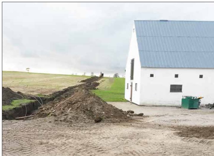
Installation av jordvärme. Vi har grävt ner slang för installation av jordvärme på en av gårdarna.
